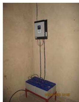
La ferme s'est dotée d'une installation solaire pour le fonctionnement de ses appareils de bureau. Elle est composée de 3 panneaux solaires, d'un convertisseur hybride et de 4 batteries blindées. L'installation solaire permettra d'alimenter au moins 3 ordinateurs, 2 imprimantes, 15 lampes et 10 portables.
