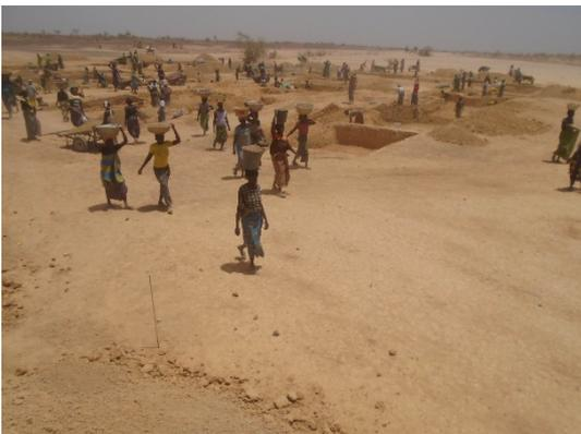
En amont du périmètre, un fort courant d'eau qui aurait pu endommager une partie du périmètre, a été identifié et aménagé. Au regard de la force du courant d'eau, il a été judicieux de **réaliser un « bulli »** (mini barrage) qui puisse contenir ce grand flux hydrique. Des équipes dynamiques (des femmes en majorité) ont pris d'assaut la réalisation de cet ouvrage et cela nous a permis de l'achever en 1 mois de travail intense.
