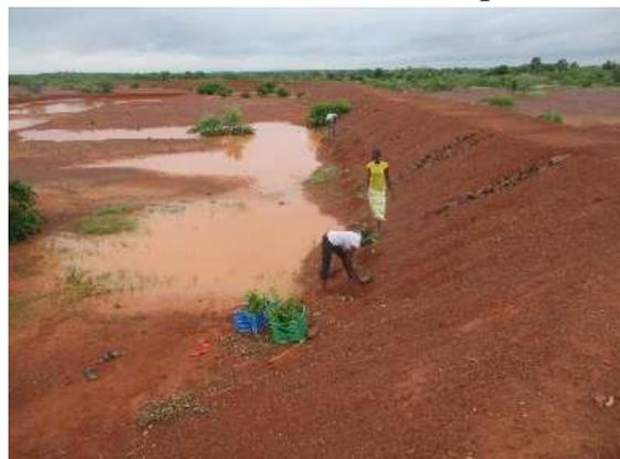
sur les cotés de la digue pour non seulement la reverdir mais aussi créer de la biodiversité car c'est une plante qui est rare à Kamsé. La digue a été également renforcée avec des morceaux de latérites dans les coins fragiles.
