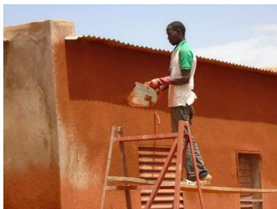
logement directeur par le crépissage, la mise de la tyrolienne (revêtement extérieure des bâtiments) et la retouche de la chaux vive à l'intérieur des logements. Nous avons aussi
