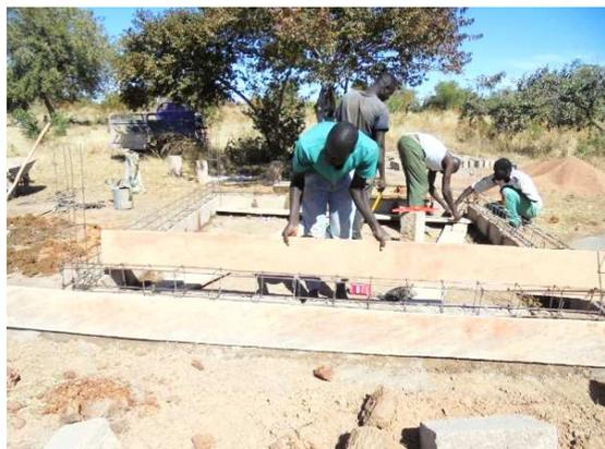
Dans la meme dynamique nous avons entrepris la construction de porte couchée, de porte barrière, un bassin définitif pour la pépinière de la ferme pilote. Le bassin permettra de stocker l'eau et faciliter l'arrosage des plants. Il a une capacité de neuf (09) m<sup>3</sup>. Pour ces réalisations nous avons fait appelle à un maçon expérimenté de l'Association ZORAMB NAAGTAABA
