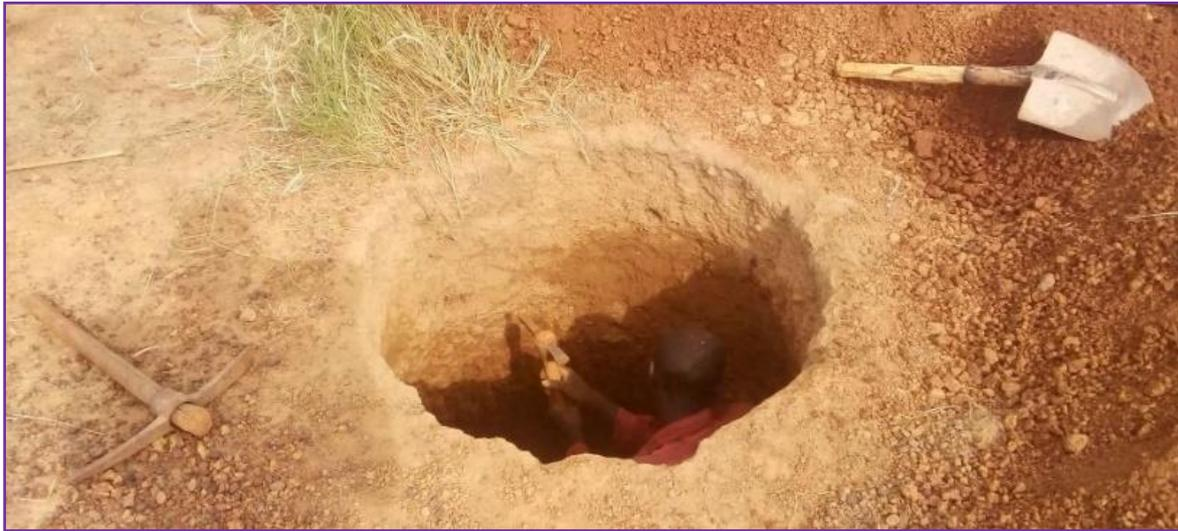
Photo 7: creusage d'un puits racinaire dans la latérite
